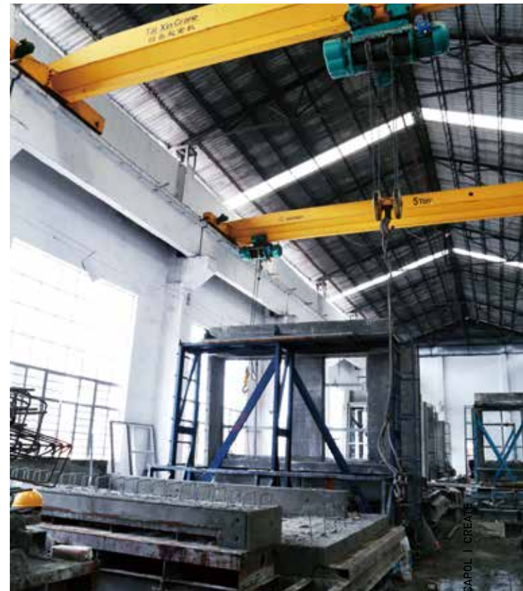
建筑部件的预制大大提高了工业化建筑的质量
