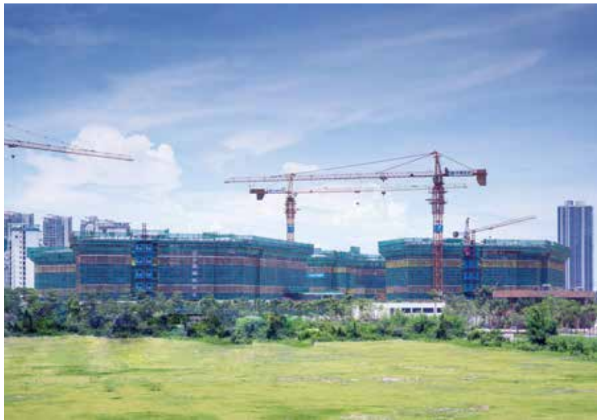
双玺花园项目方案及施工场景
